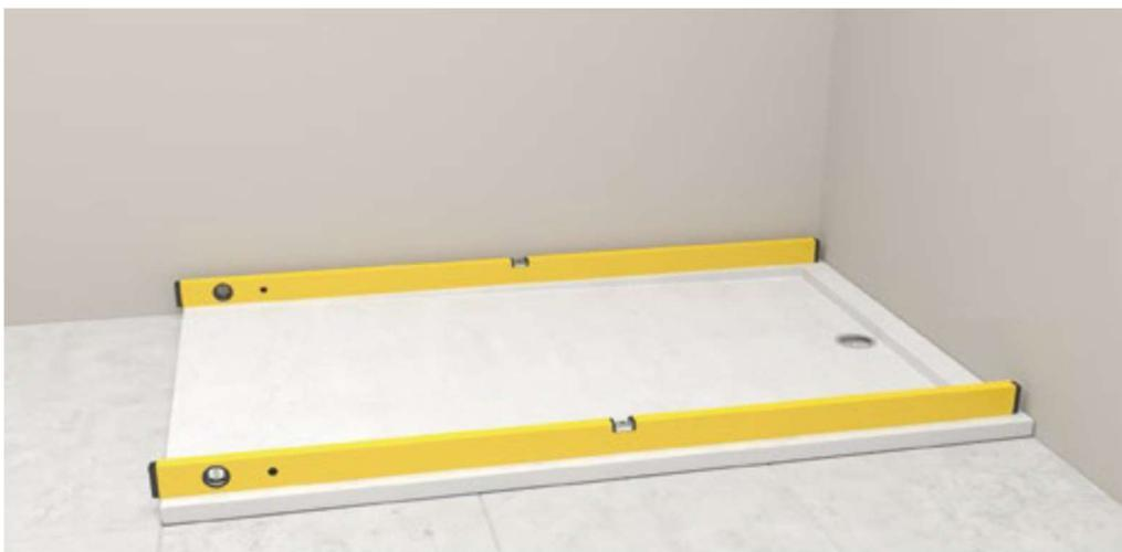
**2.** Préparez une base parfaitement plane et lisse (mortier ou similaire) ; celle-ci devra être sèche pour procéder à l'installation.
