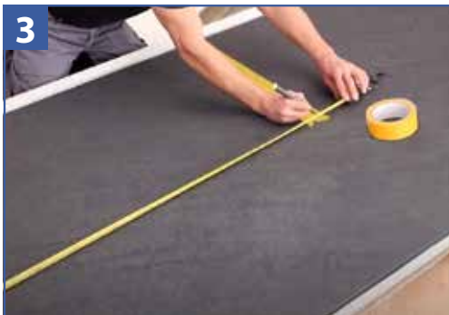
3 Reporter les cotes sur le panneau (Astuce: utiliser un adhésif de masquage léger pour reporter vos côtes).
