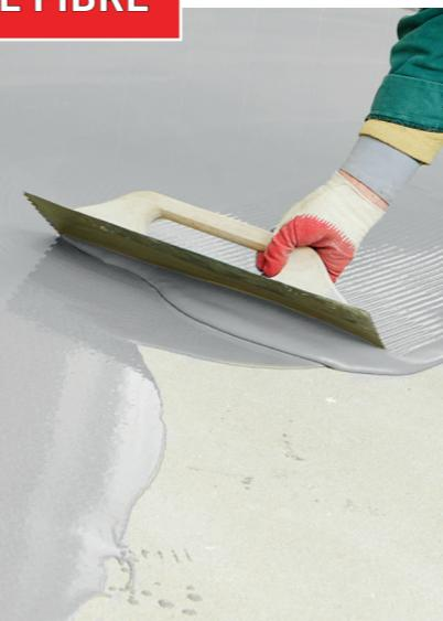
**Taux de gâchage :** 6 à 6,5 L d'eau par sac de 25 kg. Par temps froid, utiliser une eau de gâchage à plus de 10°C. Laisser reposer 2 min. Remalaxer avant emploi.
