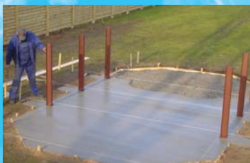
Exemple de bétonner les fossés avec les poteaux métalliques et la surface sous la piscine.
