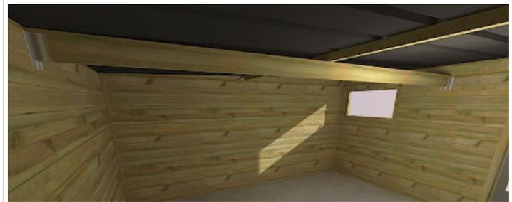
Découpez 2 supports de mur de 1,95m dans les chevrons de 3,9 m en section 45x70mm, positionnez-les au milieu des deux murs qui font plus de 4m de longueur et vissez-les (5x70mm) au niveau de chaque planche
