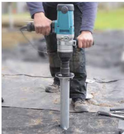
L'adaptateur 41 mm assure la connexion entre la machine (boulonneuse, visseuse) et la vis de fondation.
