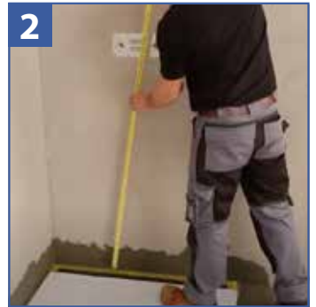
2 Relever les côtes des arrivées d'eau.
