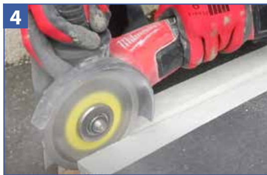
Effectuer les découpes à l'aide de disques diamant pour une découpe nette et rapide.
