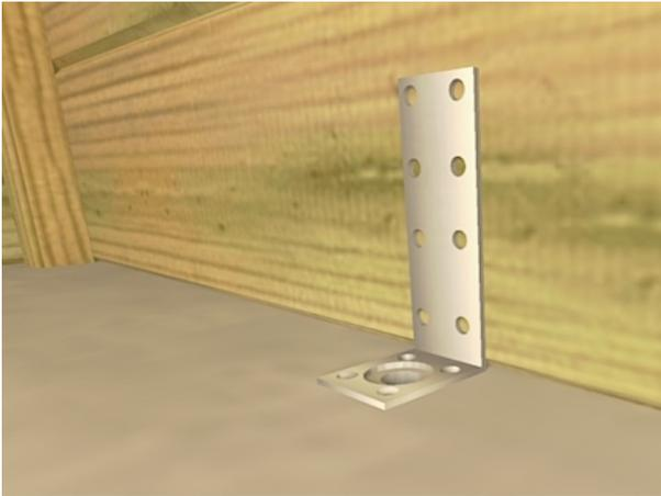
Positionnez une équerre à chaque angle du chalet au niveau du mur, percez la dalle au niveau du gros trou de l'équerre, mettez-y une cheville et vissez l'équerre dans le béton est dans le bois (4x30mm)
