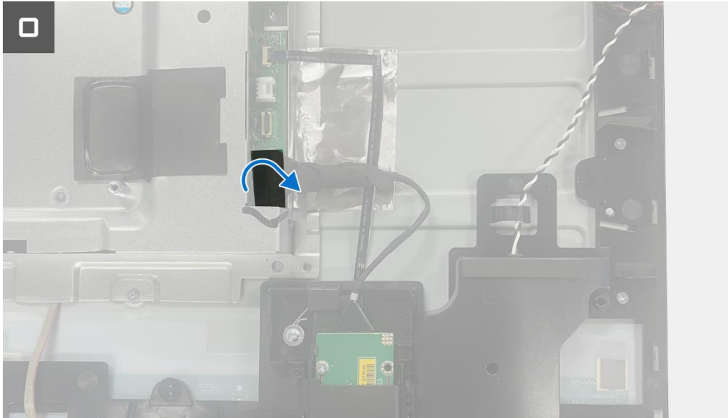
Figura 33. Instalación de la placa QAP
