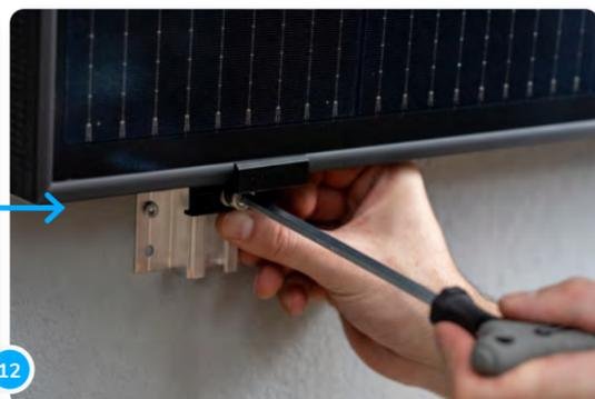
12 Quand la pince se trouve dans la position définitive, tu peux la fixer avec les vis et une clé dynamométrique (le couple de serrage à respecter est indiqué par le fabriquant).
